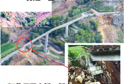
阿蘇長陽大橋 橋台の沈下・損傷
