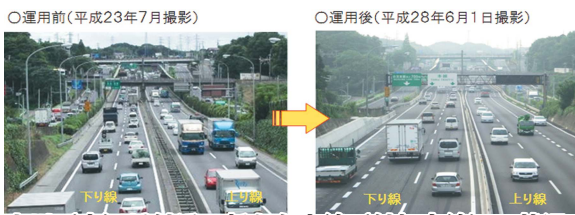
穴川(東)IC付近の新たな車線(付加車線)の状況
