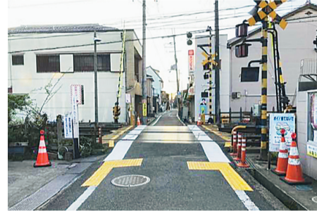
奈良県大和郡山市の事例 (歩車分離されていない道路での誘導用ブロック等の設置事例)
