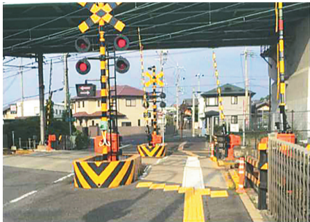
(踏切手前への視覚障害者誘導用ブロック、踏切内への誘導表示を設置した事例)
