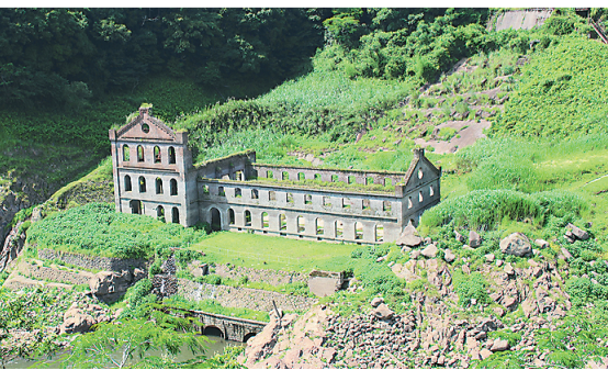
中世の遺跡を思わせる曾木第二発電所跡
