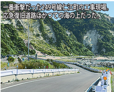
一番衝撃だった249号線仁江町の工事現場。緊急復旧道路はかつての海の上だった。
